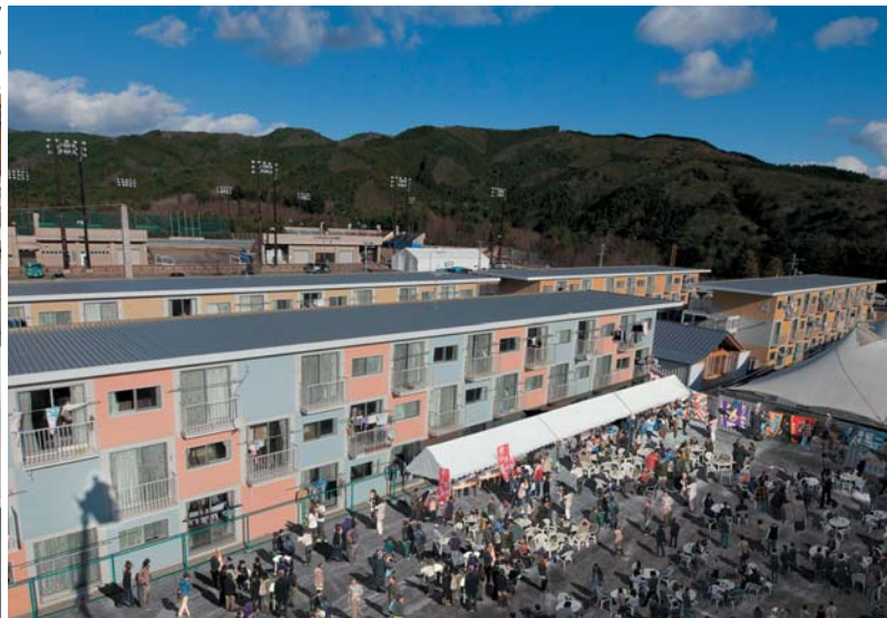
Container Temporary Housing/Onagawa, Miyagi Prefecture 2011 (c)Shigeru Ban Architects コンテナ多層仮設住宅/宮城県女川町 2011 (c)坂茂建築設計
